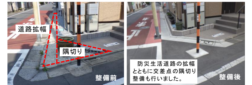
【防災生活道路の整備例(R4年度整備)】
