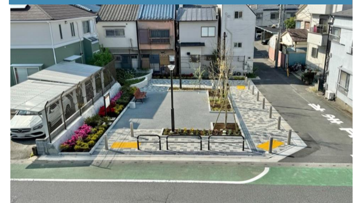
千住大川町いろどりプチテラス 住所:千住大川町32番地 (面積 187.39㎡)
