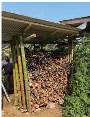
↑ 完成した薪棚
