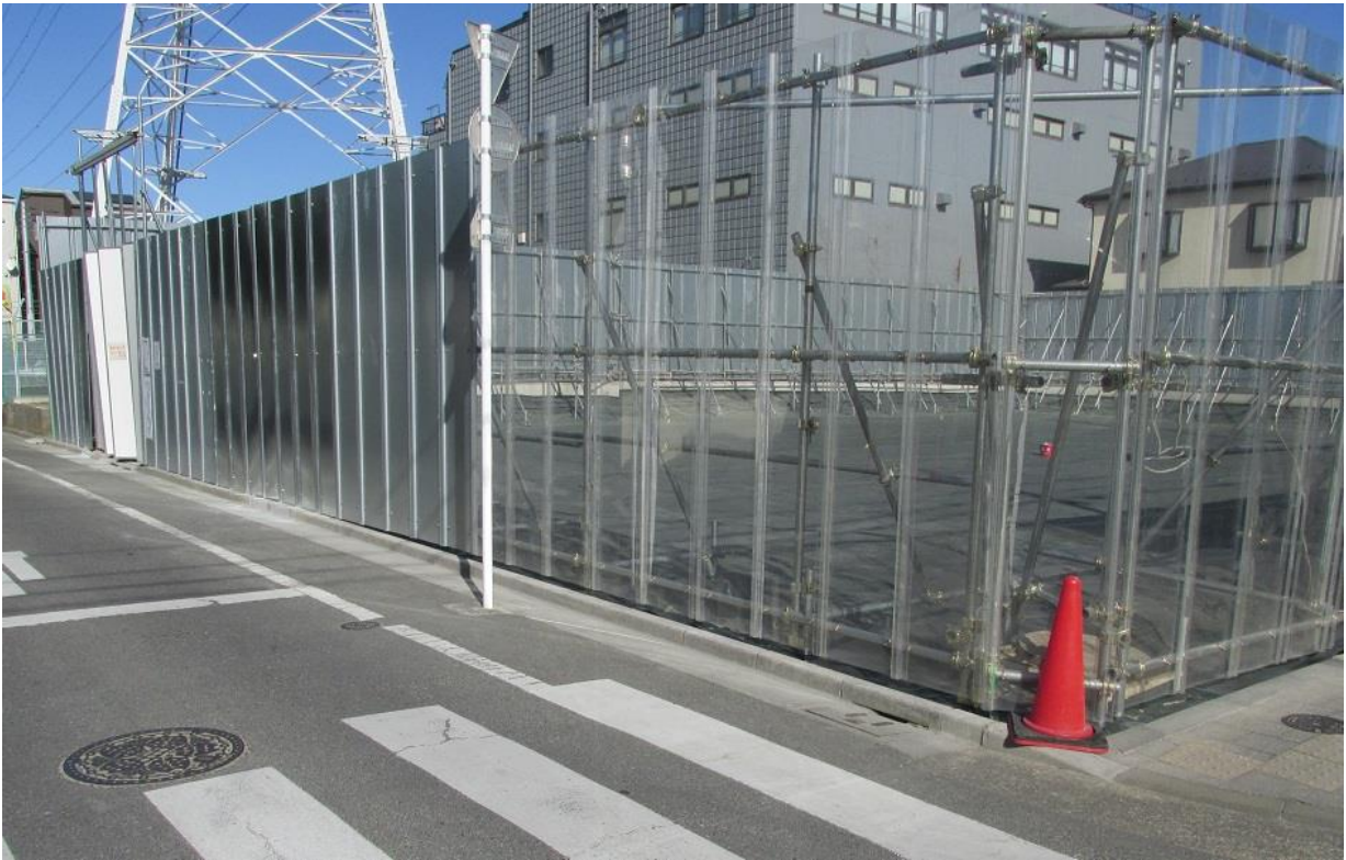
写真③（防草シート敷設後）
