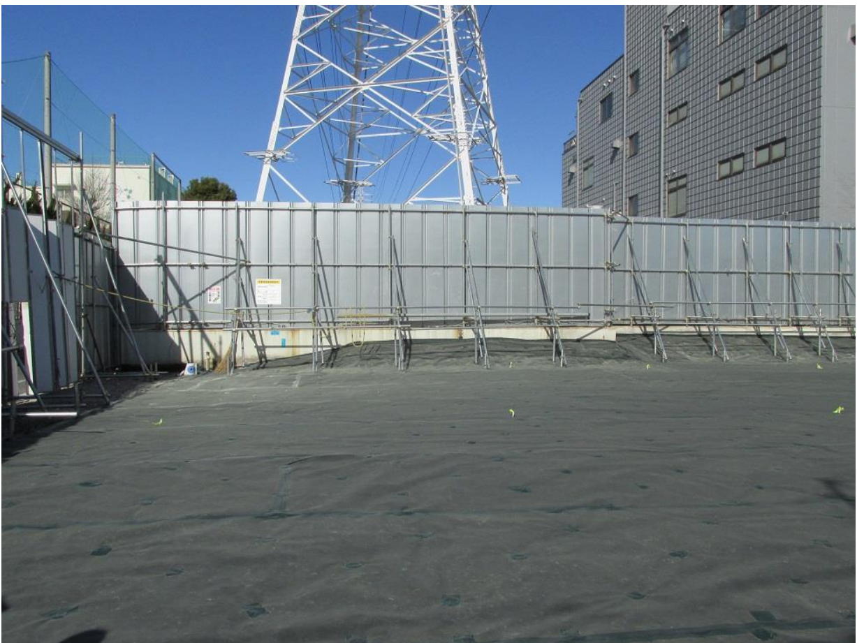
写真④（防草シート敷設後）
