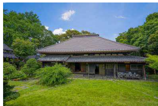
現在は瓦葺風の金属板を使用した屋根
