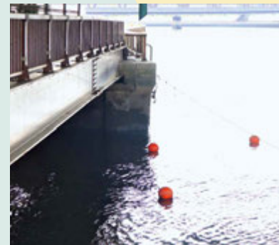
▲現在の千住大橋の下に架かる「千住小橋」からは、大橋が木造だったころの木の杭の位置を示すオレンジ色のブイを見ることができます。この杭は伊達政宗が寄進したものだといわれています
