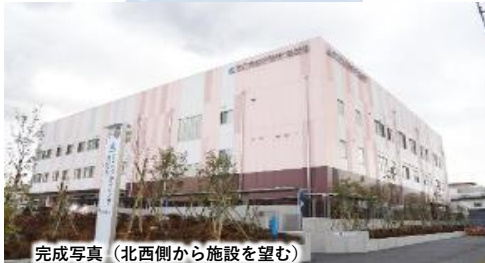
完成写真（北西側から施設を望む）
