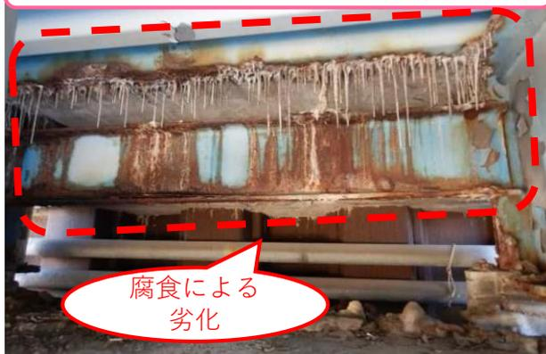
写真② 主桁の劣化状況
