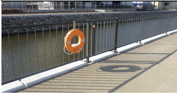
①-2 転落防止柵
