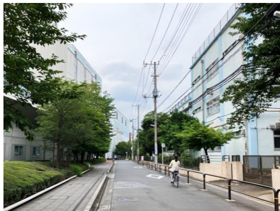
▼千寿常東小学校正門前の様子
