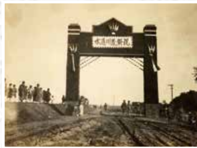
◀旧岩淵水門での通水式の様子。水門の看板には、「祝新荒川通水」と書かれている
