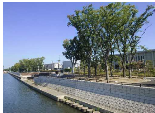
河川空間を生かして整備した公園 （毛長公園（文教大学北側））
