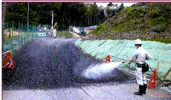
工事現場の散水状況
