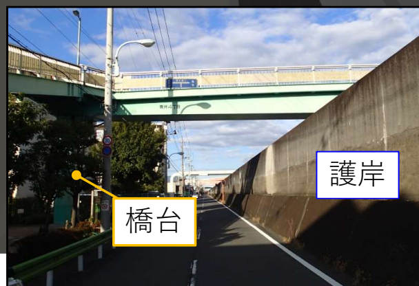
みどり歩道橋 ＜橋桁が護岸を跨ぐ形式＞
