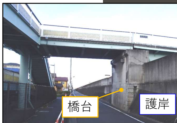
現在の五兵衛橋（右岸側） ＜護岸と橋台が一体の形式＞
