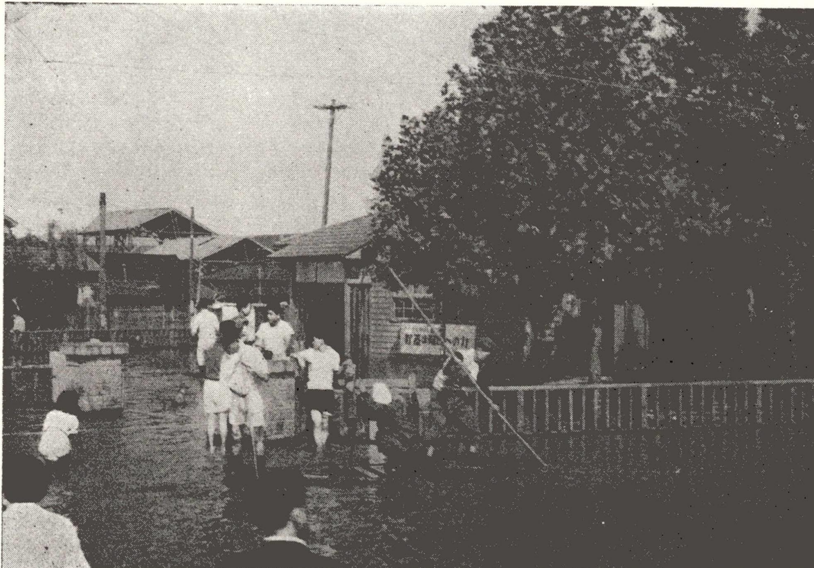
浸水被害を受けた梅島支所
