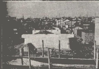
写真左は、暗渠化工事中の用水堀。右は、拡幅なった葛西用水側の道路。
