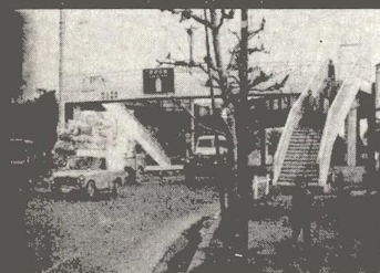
道路・横断歩道橋の建設急ピッチ
