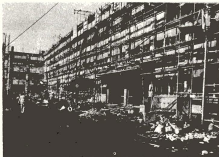
鹿浜西小の建設 (44~45年)
