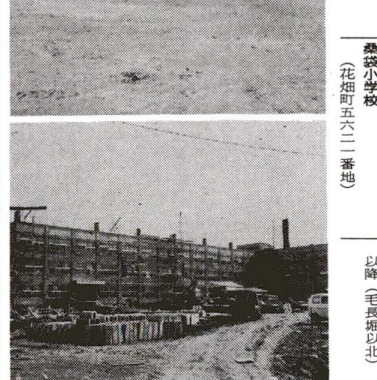
上 すっかり準備も整った桑袋小学校 下 工事も急ピッチ中島根小学校
