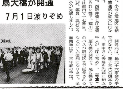
扇大橋の開通式
