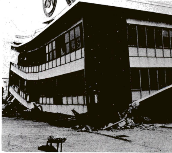
一階部分が倒壊した建物(宮城県沖地震)
