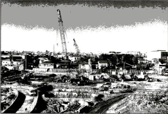
▲熊の木ポンプ所建設状況
