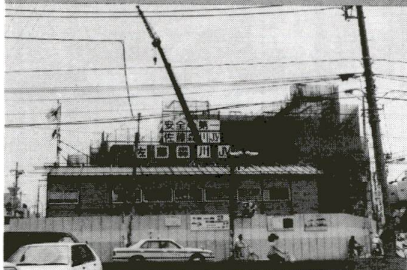
基礎工事も終わりに近づいた
