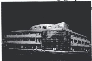
特別養護老人ホーム「さき」平成3年4月オープンをめざし10月から工事着手
