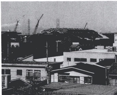
急ピッチで建設中の東京武道館
