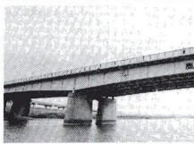
船からみた鹿浜橋
