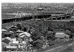
常盤線下り電車が荒川を渡る。建設中の千代田線線路が見える (昭和40年頃)
