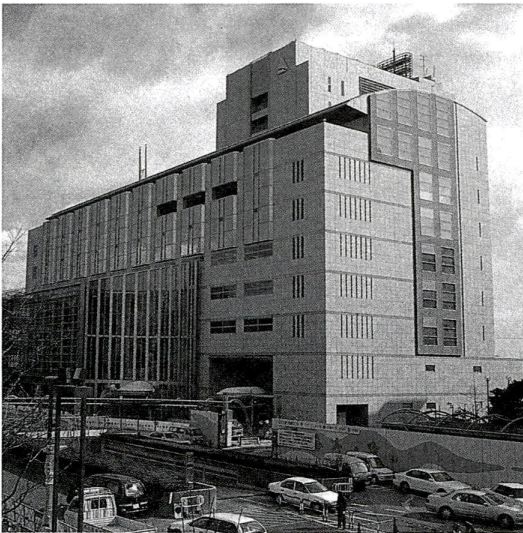
5月の開庁を目指し工事を進めています
