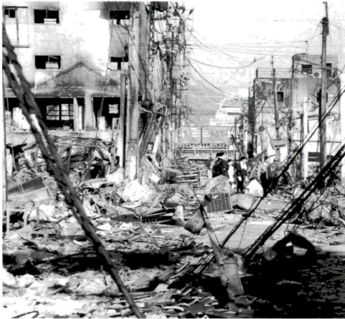
地震による火災で焼失した神戸・長田地区
