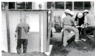
▲地下埋設式トイレの組み立て
