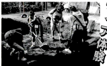
地下埋設型トイレの掘り出し作業を手伝う皆さん
