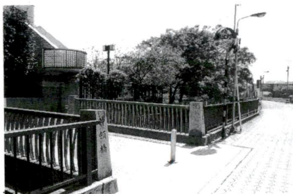
江北センター西側の神領堀とこれに架かる神領橋
