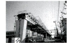
▲日暮里・舎人線の高架橋げた工事が進む谷在家付近
