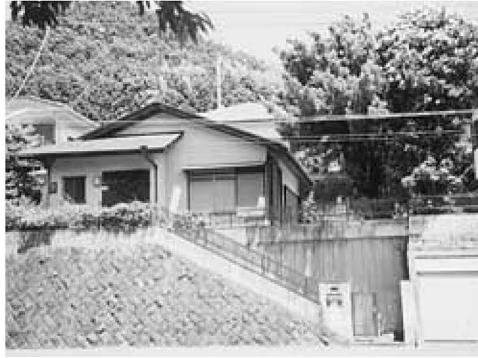
▶売却区分番号1 土地付建物
