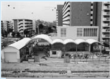
▲青井駅出入口。曲線の屋根が特徴です
