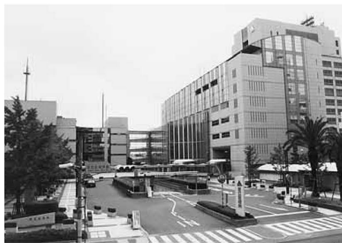
▲区役所本庁舎全景
