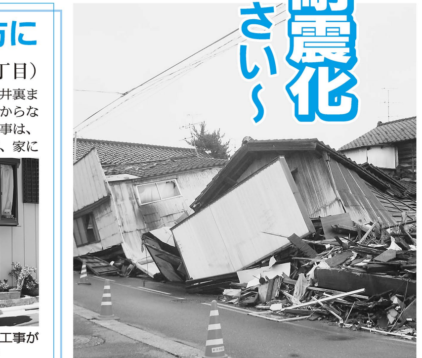
▲新潟県中越沖地震で倒壊した家屋
