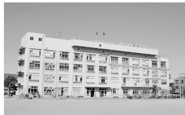
▲19年度に耐震補強工事を行った栗島中学校。生徒たちが安心して学べます
