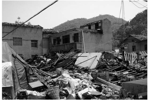
▲中国四川省の地震では、耐震性の低い建物が多く倒壊しました
