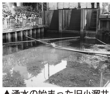
▲通水の始まった旧小溜井排水場
