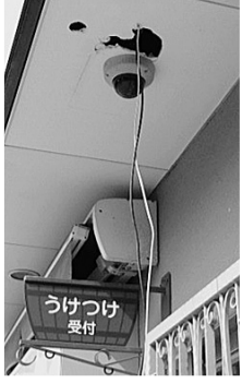
何かが壊れた(上)カメラ設置(下)
