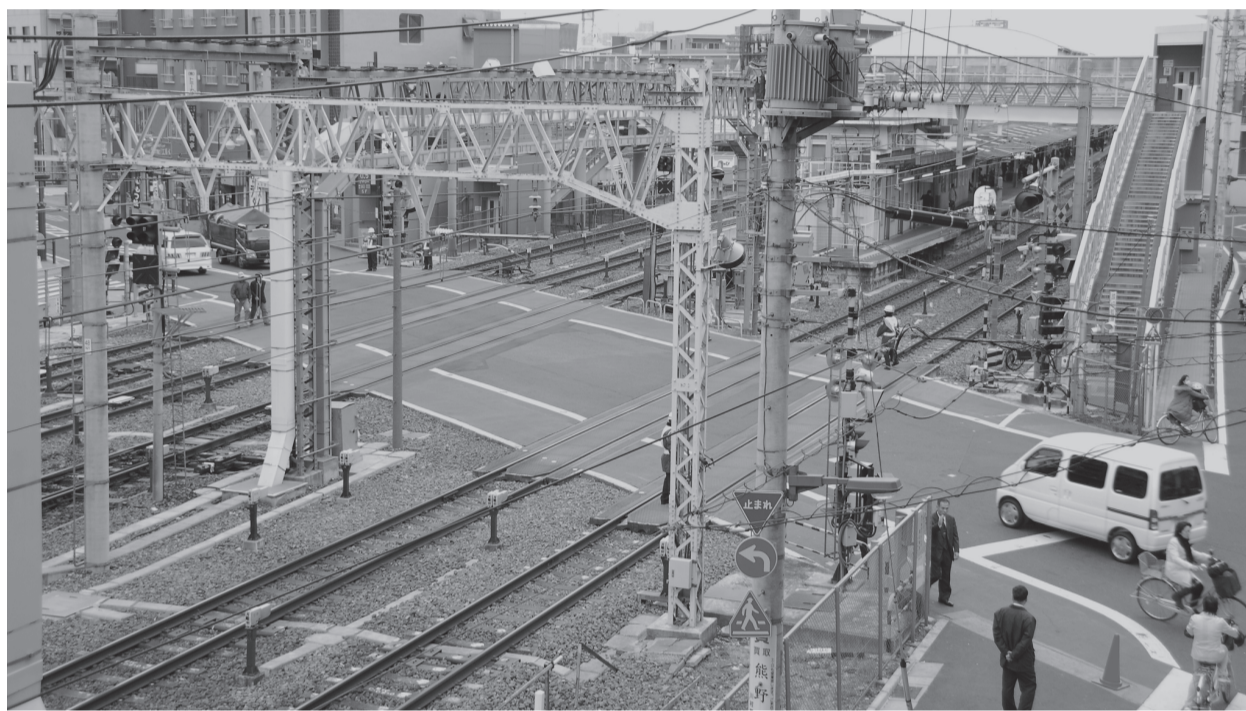
▲現在の竹ノ塚駅南側踏切(伊勢崎線第37号)付近
