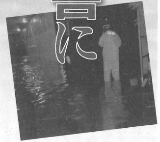
▲台風によりひごの高さまで冠水した線路下通路
