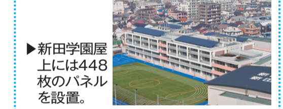
▶新田学園屋上には448枚のパネルを設置。
