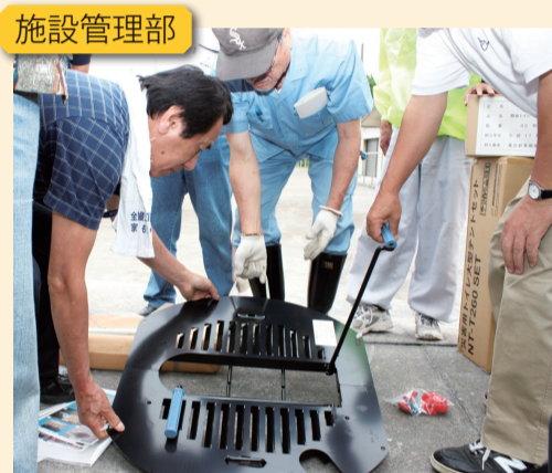
▲マンホールトイレを実際に設置
