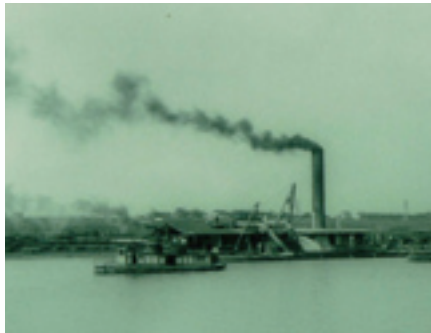
▲荒川放水路の工事の様子 写真提供：荒川下流河川事務所
