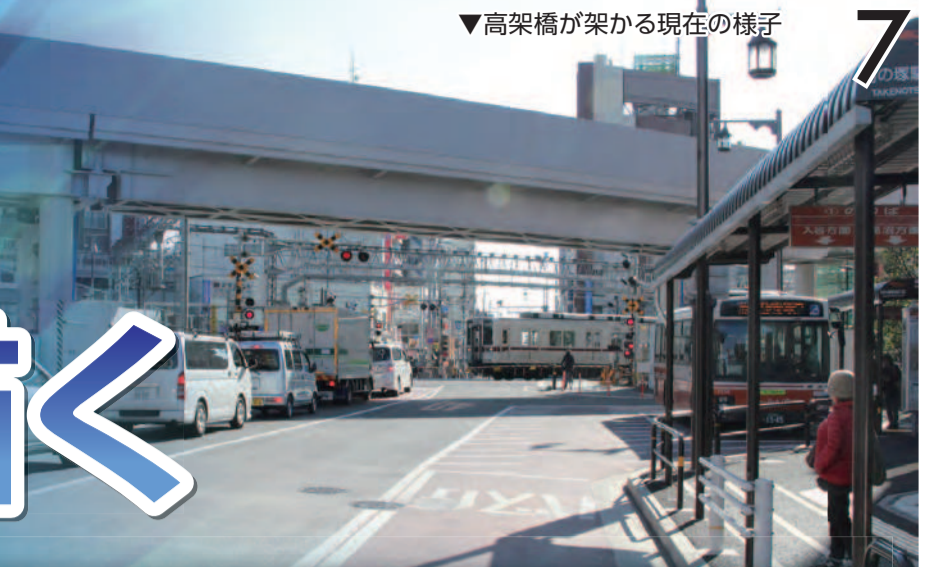
▼高架橋が架かる現在の様子
