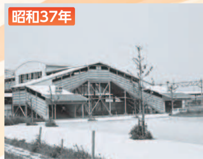
東京メトロ日比谷線が乗り入れることになったため、鉄骨造で橋上式の2階建て駅舎に作り替えられました。
