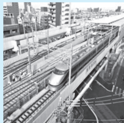
▲上下緩行線の高架化工事中
