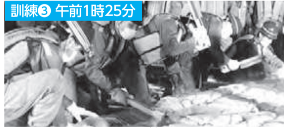
止水板をのせる準備として、叩いて土のうを平らにする
