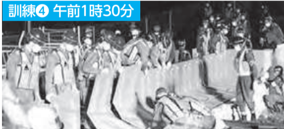
積み上げた土のうの上に、止水板を設置
