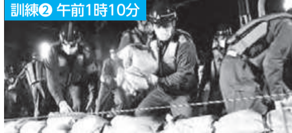
土のう約800袋を、線路上に積み上げていく
