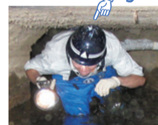
▲水路を調査する職員(平成19年撮影)
