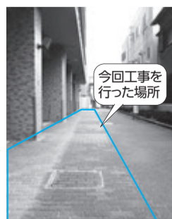
補修された歩道。段差などが無くなるように整備を行った
