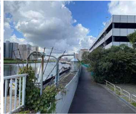
隅田川沿いの現況 (既存の防潮堤)
