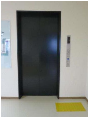
エレベーターの設置
