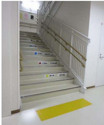
二段手すりの設置
