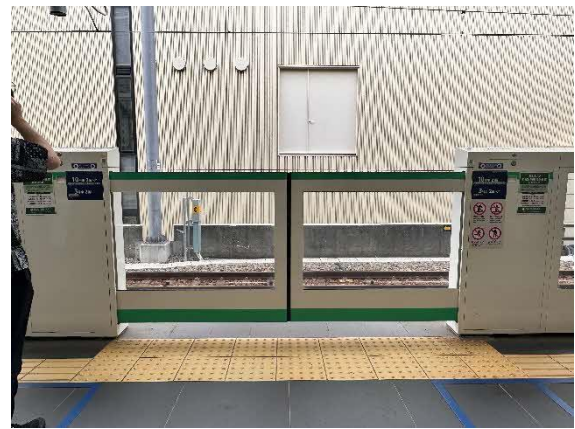
ホームドアの設置
