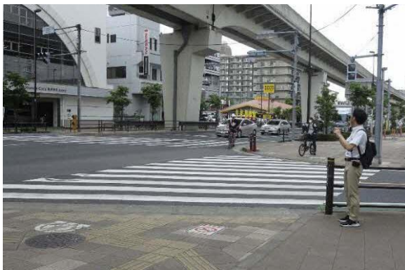
道路の無電柱化・歩道のセミフラット化
