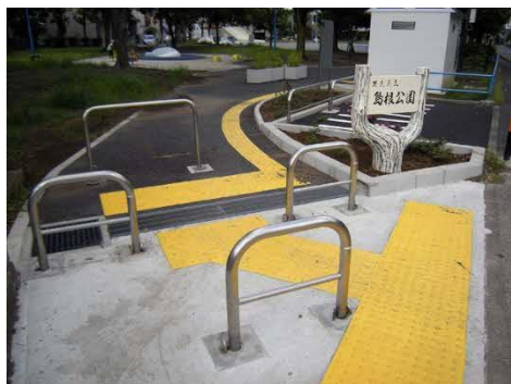
視覚障がい者誘導用シートやブロックの設置
