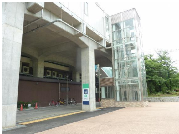
エレベーターの設置
